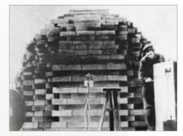
Первый исследовательский уран-графитовый реактор Ф-1. Пущен 25 декабря 1946 г. Предназначался для экспериментальной проверки осуществления и получения плутония в малых количествах
